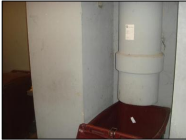
Photo N° 6155 AMIANTE CIMENT -- LOCAL VO RDC à +4 Vide-ordures Gain V.O.(Fibres-ciment)
